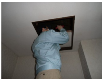
小屋組・梁の調査
