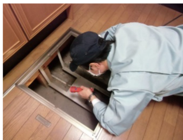
土台・床組・基礎の調査
